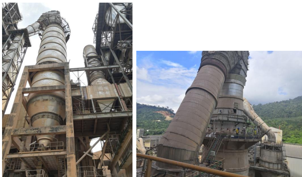
图 1 某蒸发冷却塔的现场图
